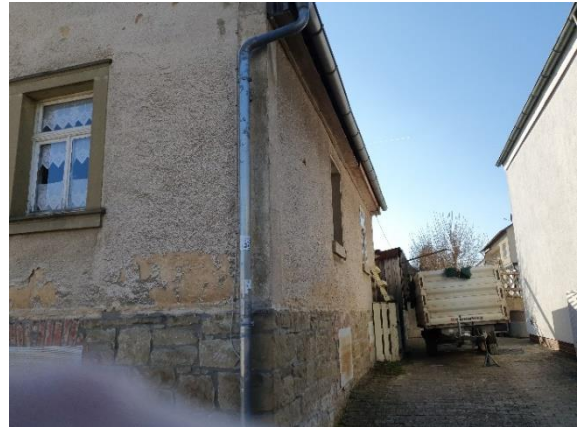
Abbildung 7: Nordseite des Gebäudes
