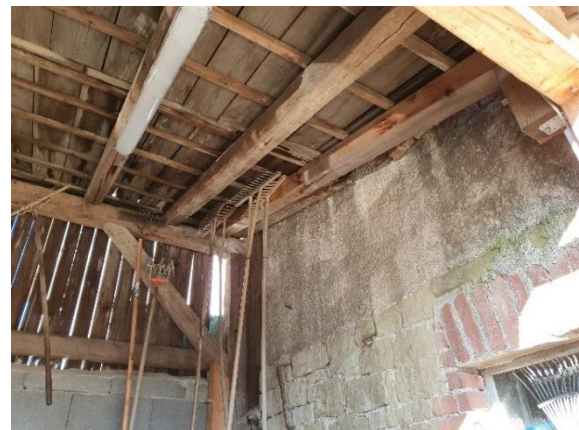
Abbildung 15: Schuppen, offener Bereich
