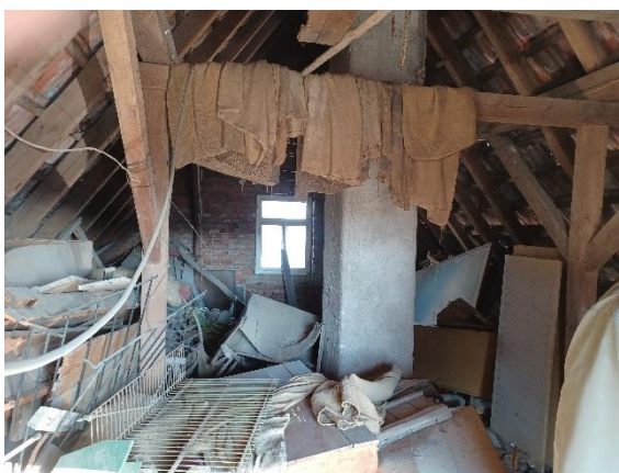
Abbildung 10: Dachgeschoss des Hauses
