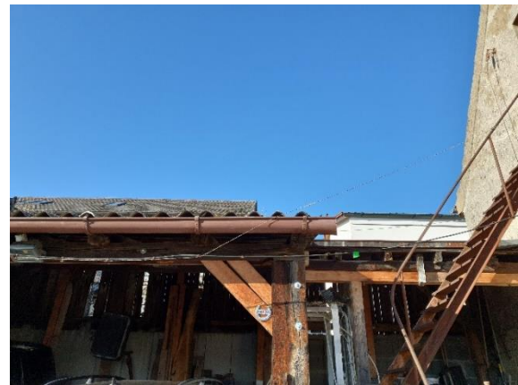
Abbildung 13: Schuppen, offener Bereich
