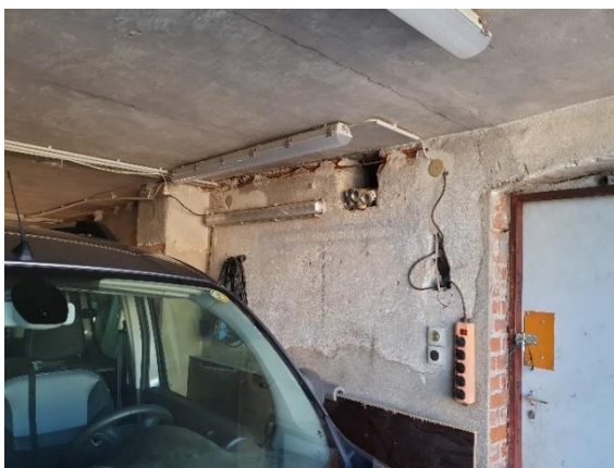
Abbildung 8: Garage im Haus
