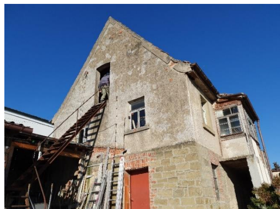
Abbildung 9: Westseite des Hauses
